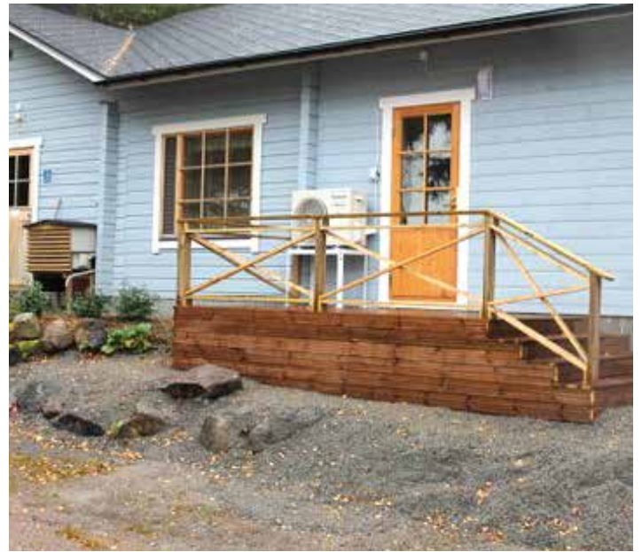
Ikkunansiirron ansiosta on isännillä näkymä myös takapuolelle.
