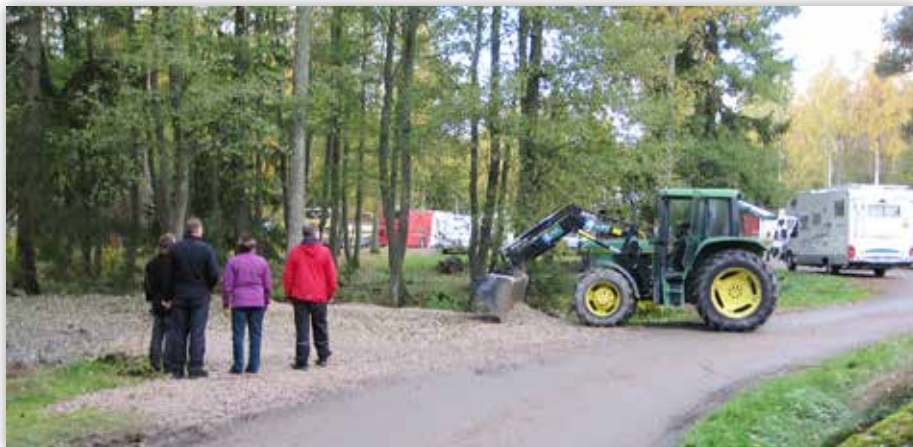
Lauantai aamuna kunnostettiin muutama keskeneräinen vaunupaikka vielä valmiiksi lauantaina saapuville vieraille
