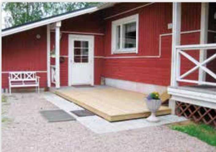
Uusi patio odottaa vielä kattoa.
