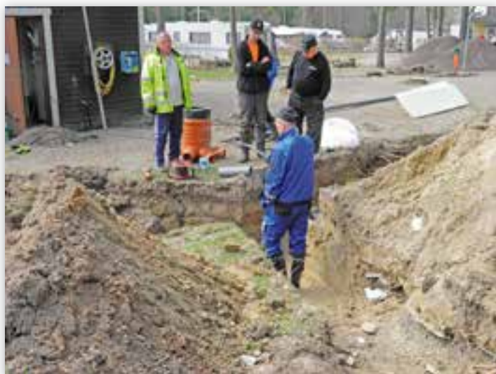
Tarkkaa touhua jotteivät putket ja kaivannot mene väärin.
