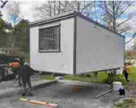
Keittiö- ja suihkukontin asennus
