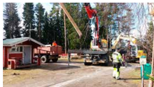
Mökin pohjan tekoa raskaalla kalustolla.
