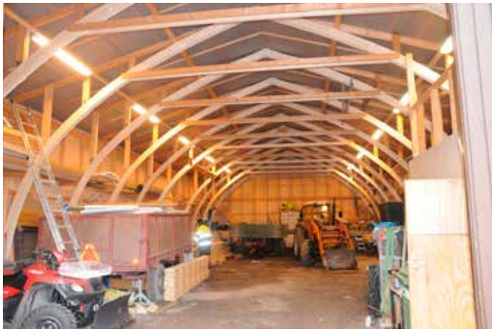
Suulin korjaus on saatu tehtyä.
