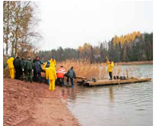
Uuden uimalaiturin asennus asennot.
