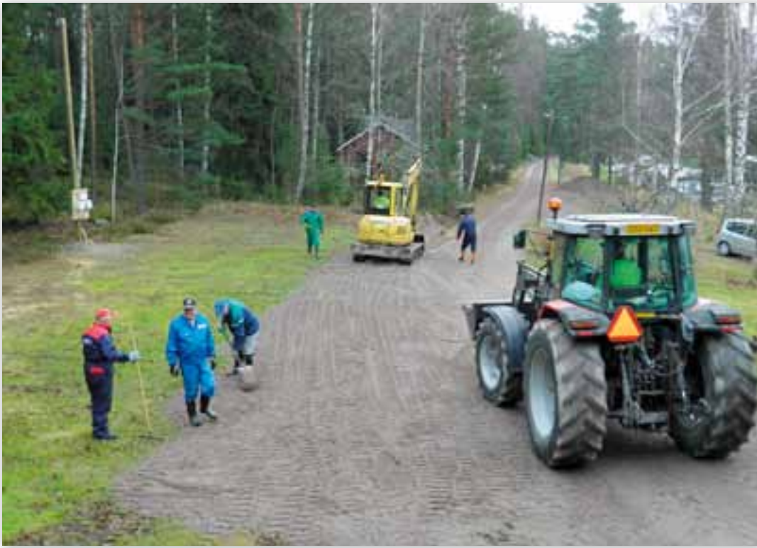
Tulevaan kesäkauteen valmistautumalla, kohenneltiin ja sähköistettiin muutamia vaunupaikkoja
