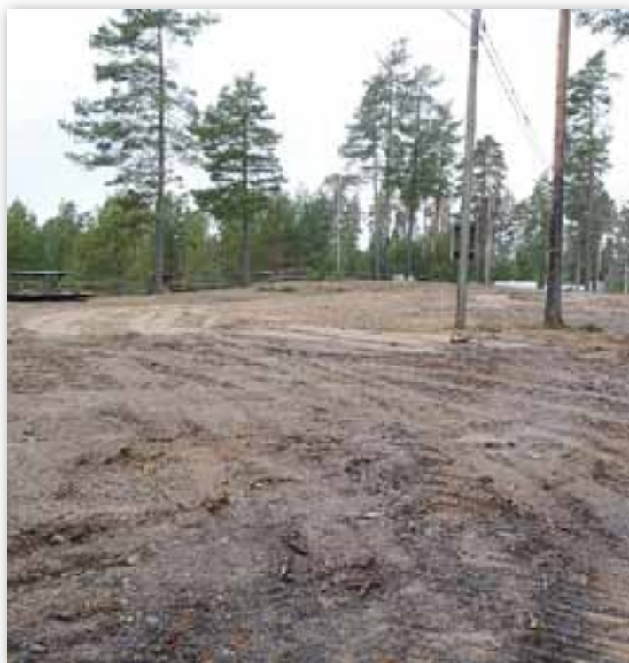
Tasointi jo hyvässä vauhdissa raivauksen jälkeen.
